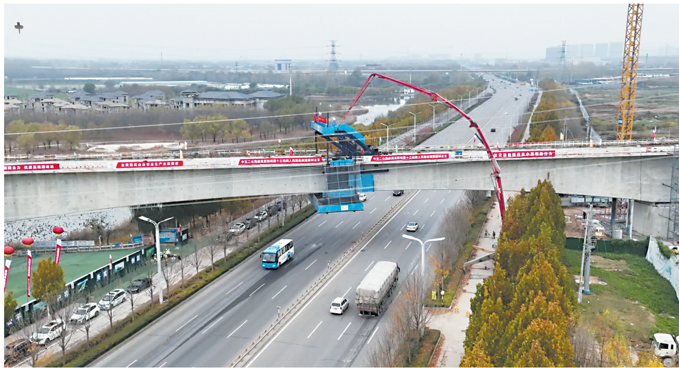
雄商高铁菏泽段跨人民路连续梁合龙施工现场。
