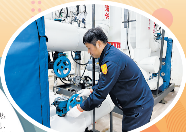
对换热站进行排查
