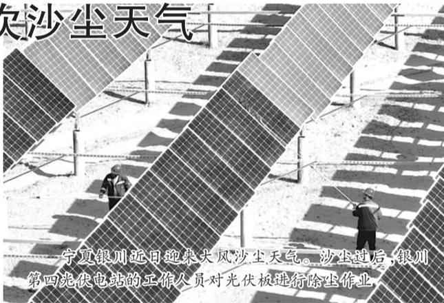
宁夏银川近日迎来大风沙尘天气。沙尘过后,银川第四光伏电站的工作人员对光伏板进行除尘作业。
