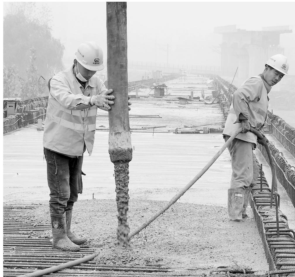
据统计,全桥上部结构施工共使用5350立方米混凝土,工期最紧张时投入4队班组,共计90余人,保证了进入今年冬季施工期之前全桥完工。
