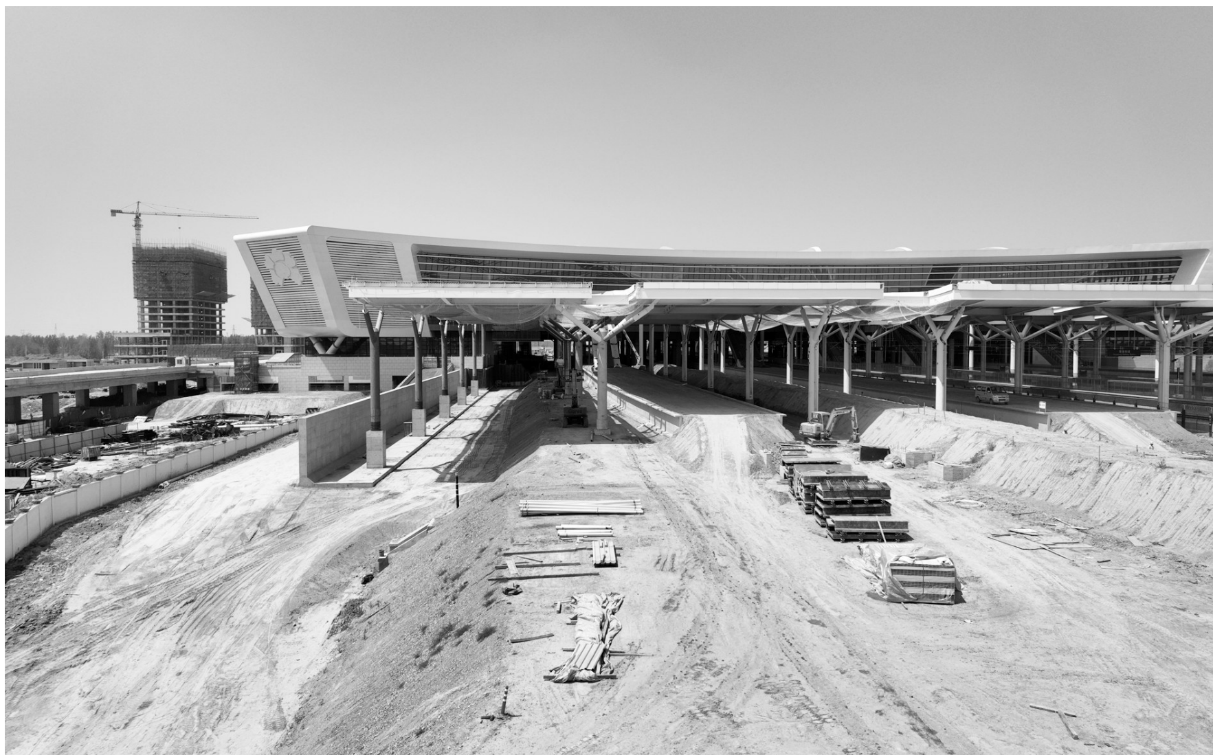
雄商鲁南高铁并行段施工现场
