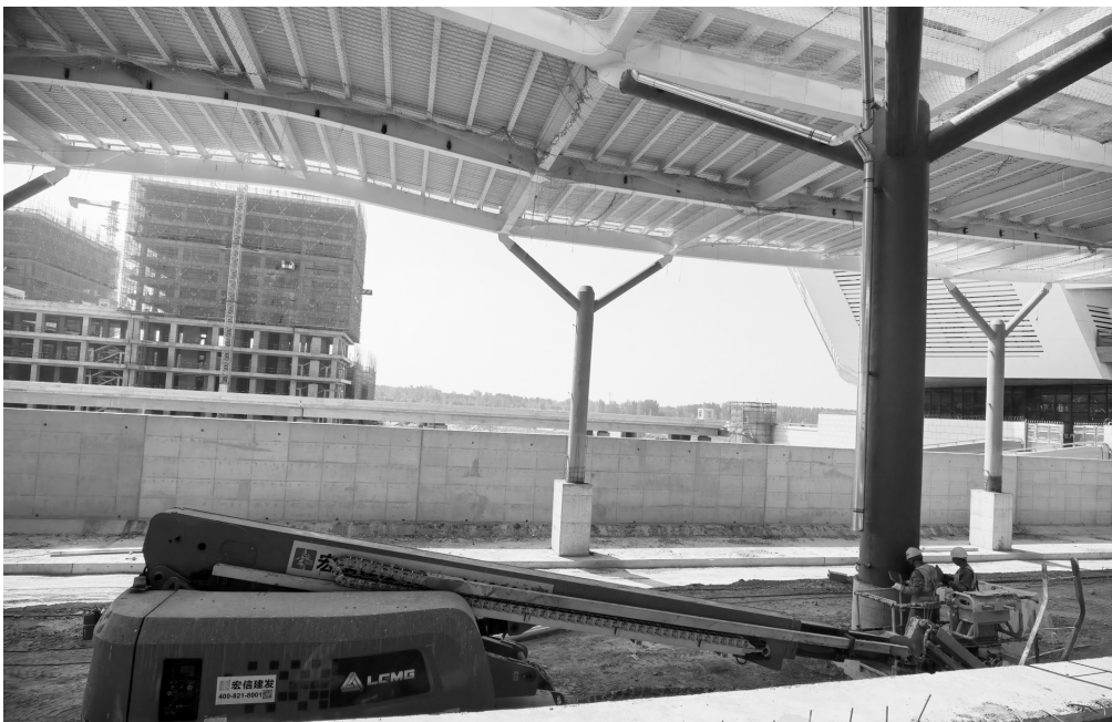
雨棚柱施工
