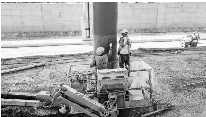
在雨棚柱上覆盖防裂材料
