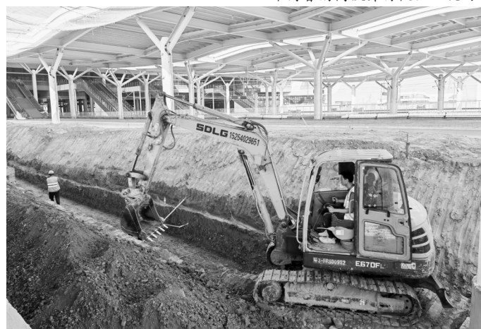
站台附属的水沟施工
