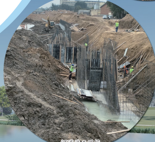
河道施工现场
