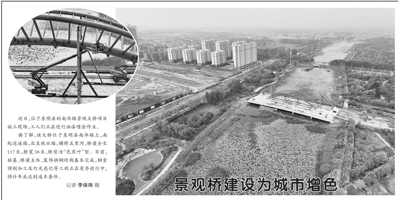
近日,位于东明县的南华路景观大桥项目施工现场,工人们正在进行油漆喷涂作业。据了解,该大桥位于东明县南华路上,南起道路,北至秋水路,横跨五里河,桥梁全长117米,桥宽38米,桥型为“芭蕉叶”型。目前,桩基、桥梁主体、装饰拱钢结构基本完成,钢索预制加工及灯光亮化等工程正在有序进行中,预计年底达到通车条件。
