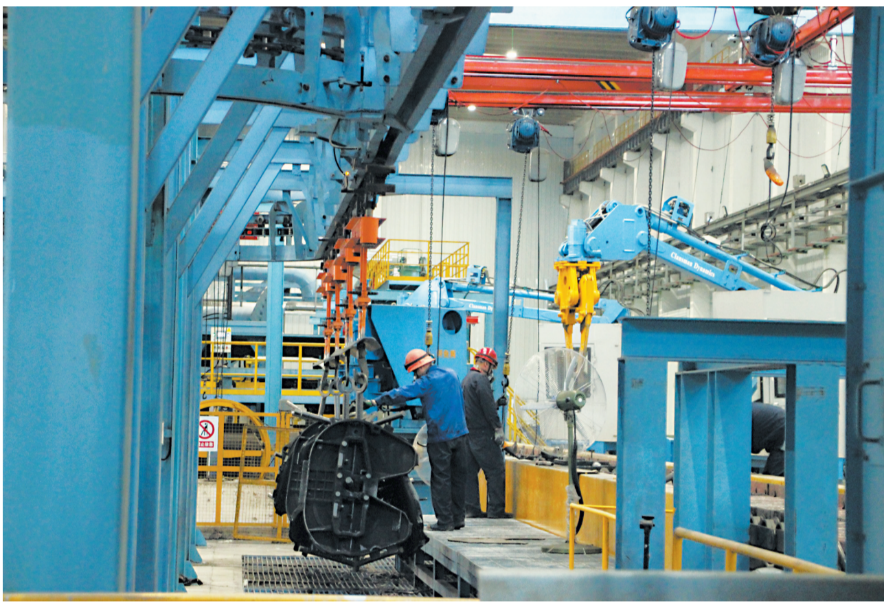
单县湖西王智能化生产技术改造项目现场,工作人员正在作业。该项目技术改造完成后,可实现智能化上下料、自动浇注、自动在线检测等,大大提高生产效率。 记者 胡德光 摄
