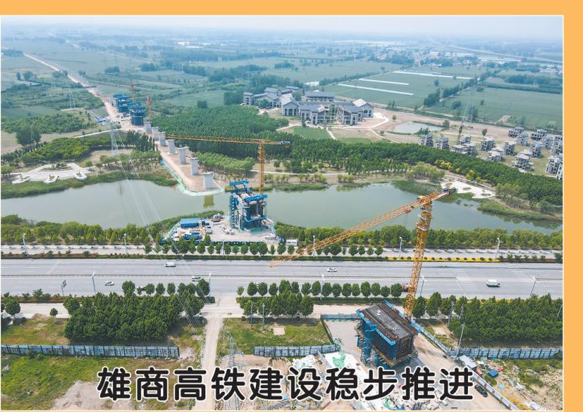
5月6日,雄商高铁(菏泽段)站前十三标上跨人民路连续梁施工现场,施工人员进行连续梁1号块钢筋绑扎作业。目前该标段桩基已基本完成,墩柱已完成98%。其中,跨人民路128米连续梁0号块段混凝土已浇筑完毕,正在进行1号块挂篮施工作业,该连续梁预计11月中旬完成合龙,其余连续梁工程按照施工计划稳步推进中。 记者 李保珠 摄
