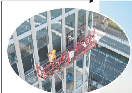
日前,雄商高铁菏泽东站东广场项目施工现场,施工人员正在商业综合东塔楼进行玻璃幕墙安装作业。据了解,菏泽东站西广场面向老城区,定义为主要交通发展广场,目前已建成并投入使用;东广场面向新城区,定义为城市发展广场。目前,东广场项目主体全部完工,匝道、土方回填、地下工程均已完工,消防、水电、幕墙、室内外装修正在有序施工中。
