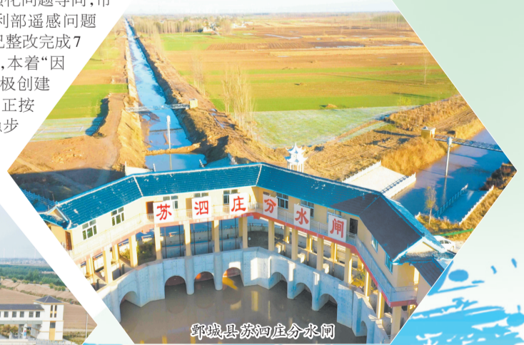
鄆城县苏河庄分水闸
