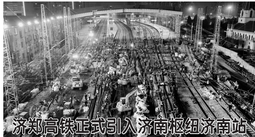
11月15日夜间，在济南火车站，中铁十局的工作人员正在对济郑高铁引入济南站进行站改作业（无人机照片）。 11月16日凌晨，在济南火车站，由中铁十局承建的济（南）郑（州）高铁山东段引入济南枢纽济南站改工程顺利完成。作为济郑高铁的控制性工程，本次施工需要在7个小时内，工务、电务等专业同步作业，完成线路拨接、大机捣固、信号设备倒接启用、接触网改造等多项站改任务。 据悉，济郑高铁是国家“八纵八横”高铁网重要连接线。项目建成后，将构建起山东半岛与中原及西部地区联系的快速客运通道。 新华社记者 郭绪雷摄
