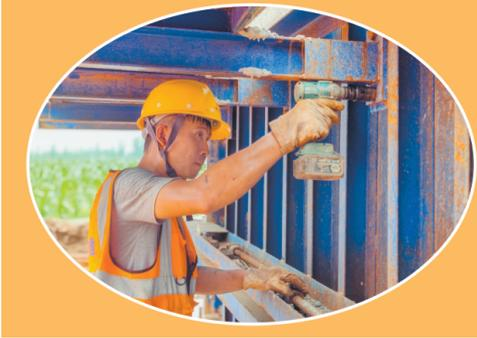
7月13日,在雄商高铁菏泽段施工现场,一座座已完成浇筑的灰白色墩柱拔地而起,桩基、承台、墩柱等项目施工热火朝天,工人们手持扳手正在进行墩柱模板安装作业。目前,雄商高铁菏泽段桩基施工已全面展开,墩柱施工同步进行中。雄商高铁与鲁南高铁在我市“十”字交汇,对于推动我市加快构建现代化综合交通运输体系,加快实现高质量发展具有十分重要的意义。
