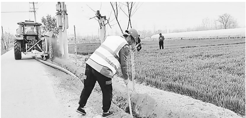
农村供水提质升级 村民喝上“幸福水”
