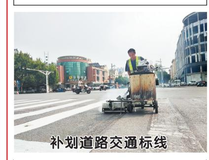
清扫路面、打底线、刷底漆、划标线……9月13日,在市区八一路华英路 交叉口,工人们正在按照步骤有条不紊地开展道路标线补划作业。
