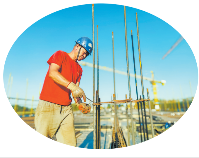
菏泽智慧冷城项目建设快速推进
