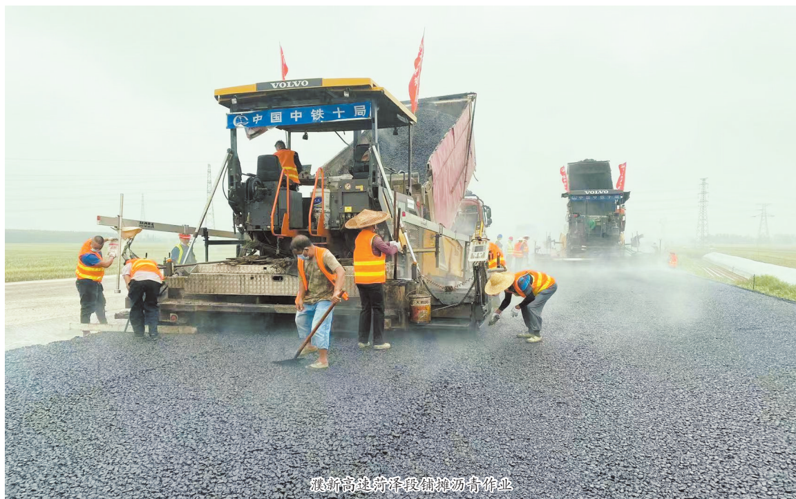
濮新高速菏泽段摊铺沥青作业
