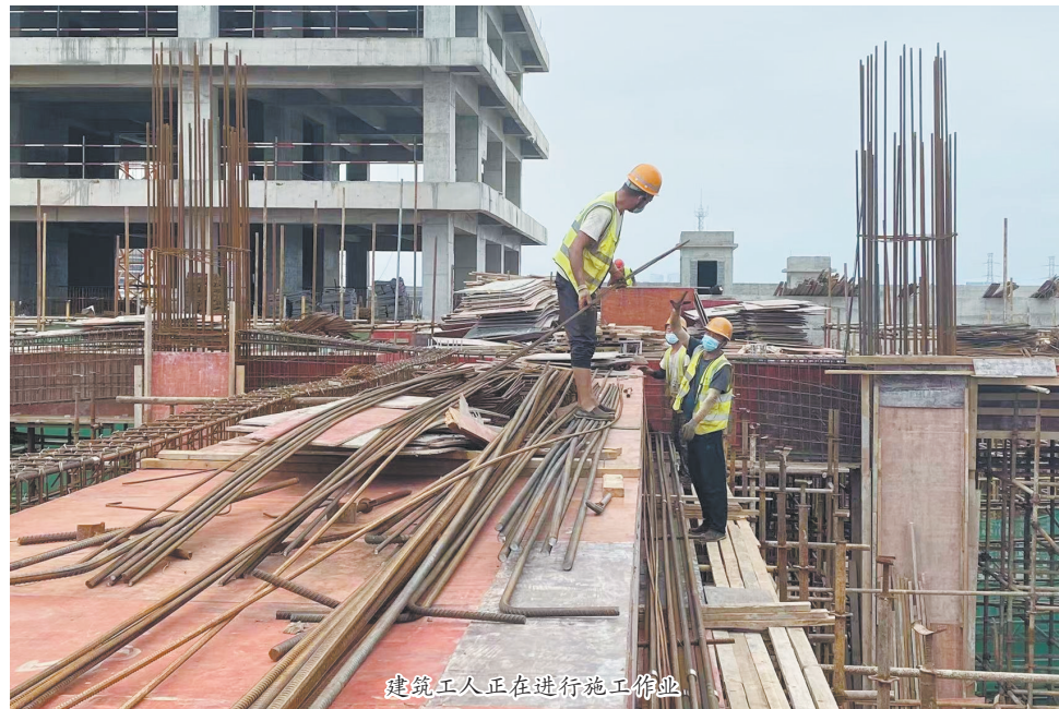
建筑工人正在进行施工作业
