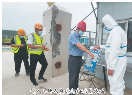
进入工地人员进行扫码量体温
