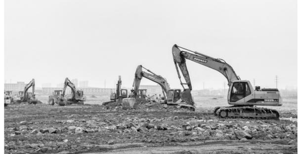
3月13日,工程机械在吉林市高新南区隔离方舱施工现场施工。3月13日,吉林省吉林市高新南区隔离方舱开工建设。项目总用地面积约43万平方米,总建筑面积约17.51万平方米,共设计6000间隔离房间。目前,施工单位吉林市市政集团组织工人近2000人、各类机械设备300余台,正在进行场地平整工作,供电、供水工作同步开展。
