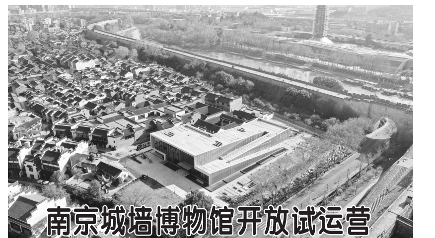
南京城墙博物馆开放试运营。12月28日拍摄的南京城墙博物馆及周边景色(无人机照片)。当日,南京城墙博物馆开放试运营。南京城墙博物馆位于中华门瓮城东侧,总建筑面积约13000平方米。南京城墙博物馆展出各类精品文物2000多件(套),从设计思想、筑城技术、遗产传承等方面,展现南京城墙的历史文化及遗产价值。新华社记者 季春鹏摄
