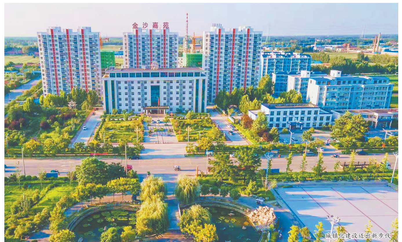
光伏发电产业园一角
