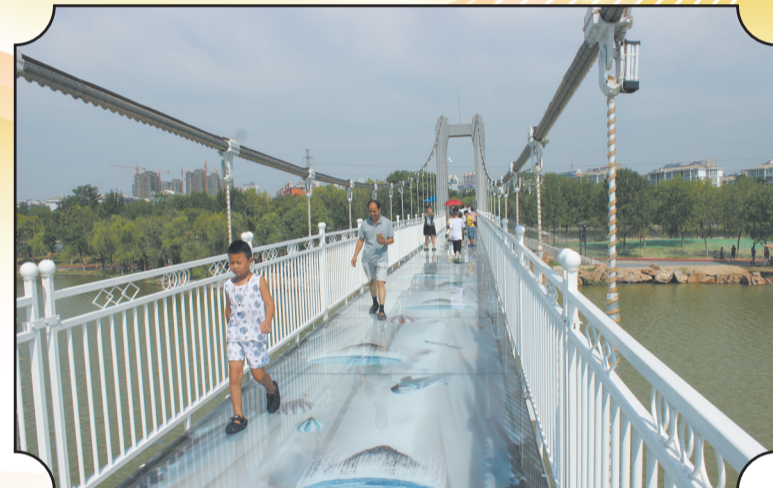
单县城区重要旅游景点——玻璃栈桥
